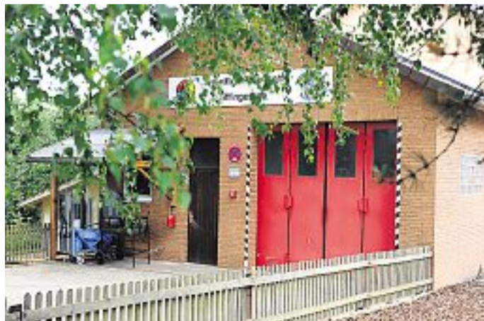
Viel zu klein: Feuerwehrhaus in Tiftlingerode.
